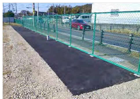
【防草用アスファルト舗装・施工状況（立花寺二丁目）(R8. 3)】
