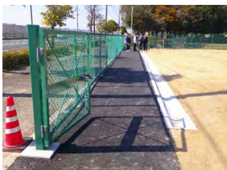
【防草用アスファルト舗装・施工状況（月隈一丁目）(R8. 3)】
