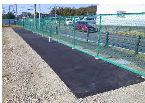
②【防草用アスファルト舗装・施工状況(立花寺二丁目)】
