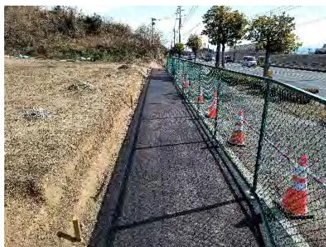
②【防草用アスファルト舗装・施工状況(立花寺二丁目)】
