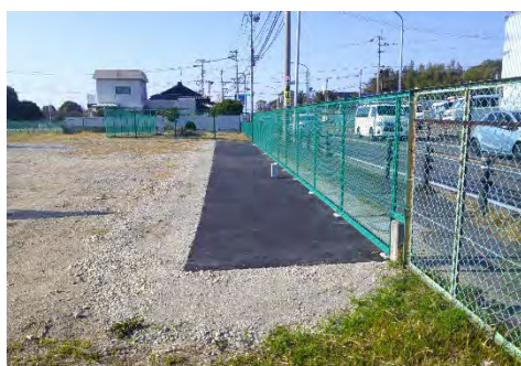
②【防草用アスファルト舗装・施工状況(立花寺二丁目)】
