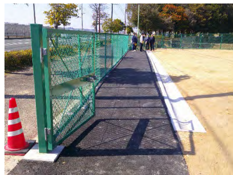
②【防草用アスファルト舗装・施工状況(立花寺二丁目)】
