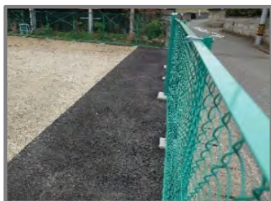
アスファルト施工直後(R7.3)
